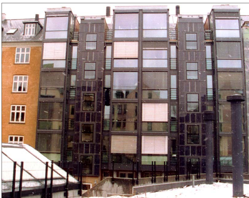
Gårdfacaden til Sundevedsgade 26-28 er helt dækket af nye glaspartier. Monokrystallinske solceller er integreret i bitrappetårnenes facader mod sydvest.
