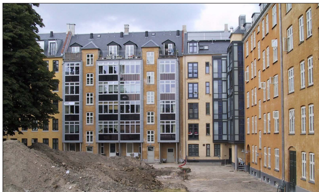
Gårdfacader i Tøndergade og Sundevedsgade. På afstand fremstår solcellepanelerne som helt jævne, mørkebrune flader.
