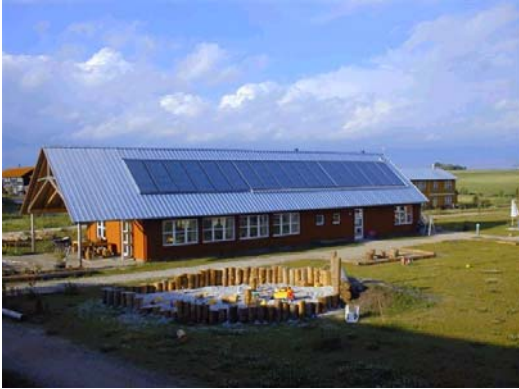
Solfanger til opvarmning af brugsvand
