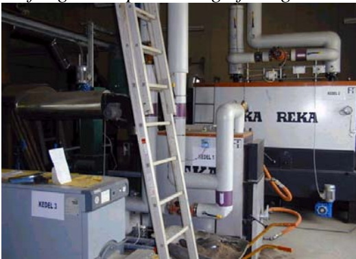
Billede af træpillefyr og oliefyr
